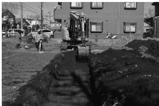
本村遺跡第 140 地点調査風景
