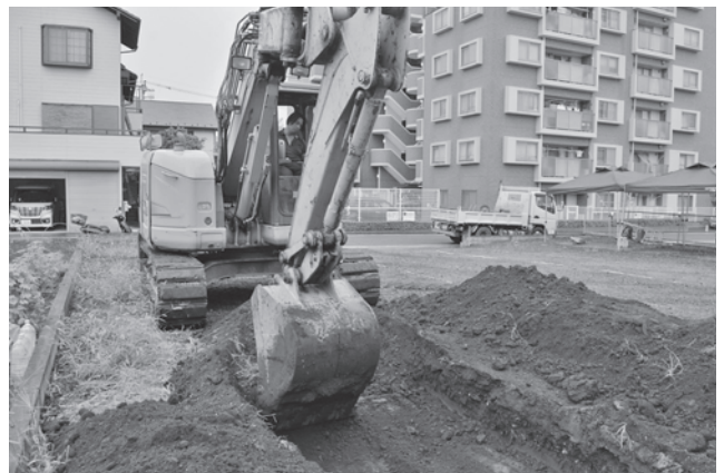
本村遺跡第 141 地点調査風景
