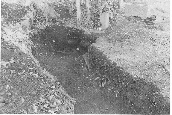
湧水口(第1トレンチ)
