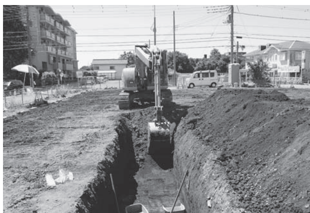
東台遺跡第 58 地点調査風景
