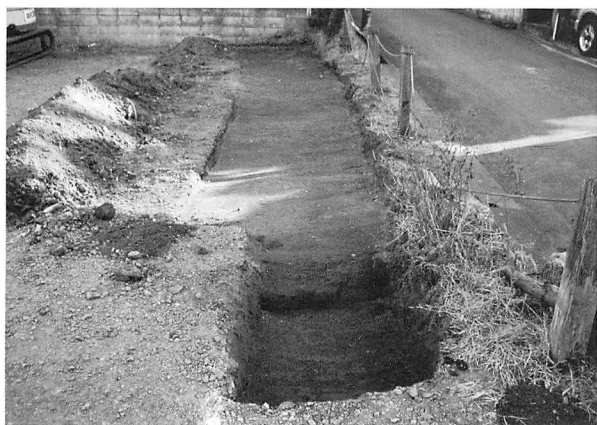
西台遺跡第4地点試掘調査
