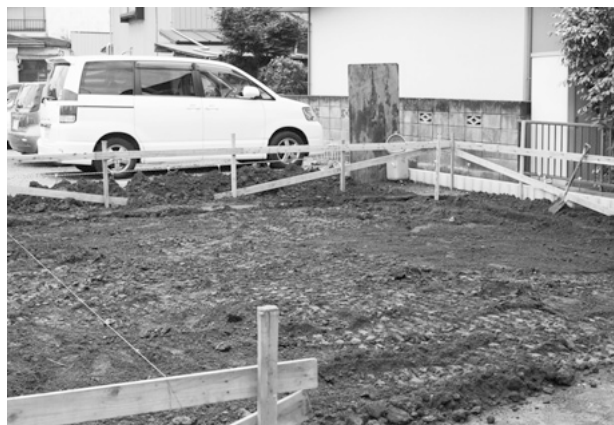
北野遺跡工事立会い
