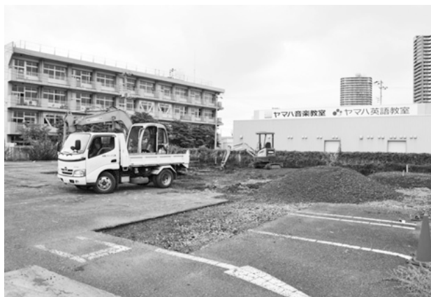
東中学校西遺跡工事立会い
