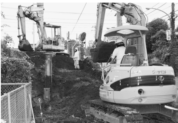
埼玉県教育委員会大井戸上遺跡試掘調査立会い
