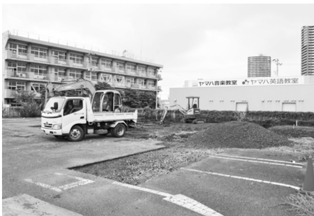
東中学校西遺跡工事立会い
