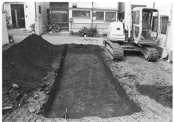
江川東遺跡第6地点トレンチ
