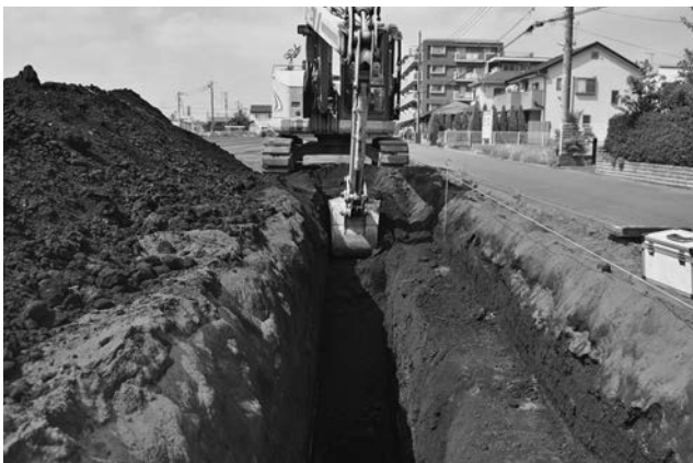
亀久保堀跡遺跡第 34 地点調査風景①
