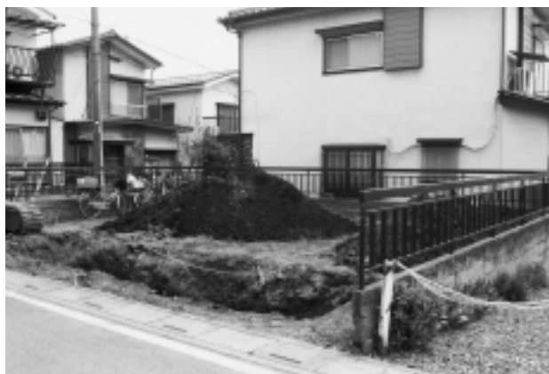
亀居遺跡第58地点調査区近景
